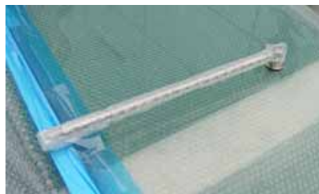
吊り材の保護
